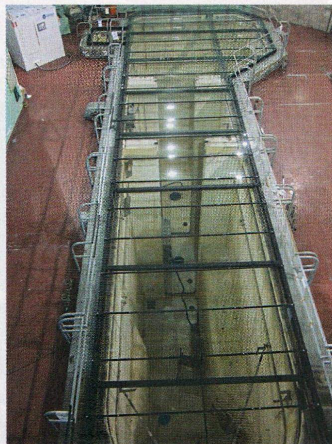
A sinistra: immagine fotografica della piscina del reattore RTS-1 GALILEO GALILEI quando era operante (archivio storico CISAM). A destra: la sala vasche del reattore RTS-1 come si presenta oggi, dopo lo svuotamento dell'acqua e la copertura con una piastra di plexiglas di protezione. (foto: archivio storico CISAM)
